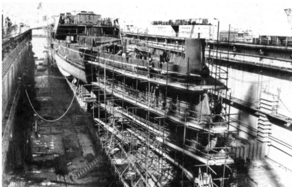
Корпус крейсера в доке судостроительного завода имени А.А.Жданова в процессе «расчленения», 1985 г.
