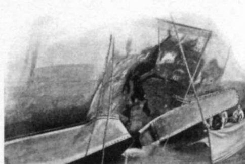
Крейсер «Паллада» в доке: пробоина от японской торпеды, поразившей корабль в ночь на 27 января 1904 г.
